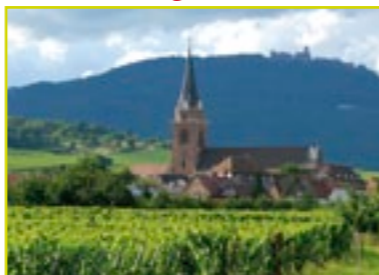
Église de Bergheim.
