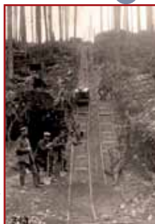
Câble transbordeur allemand du Barrenkopf
