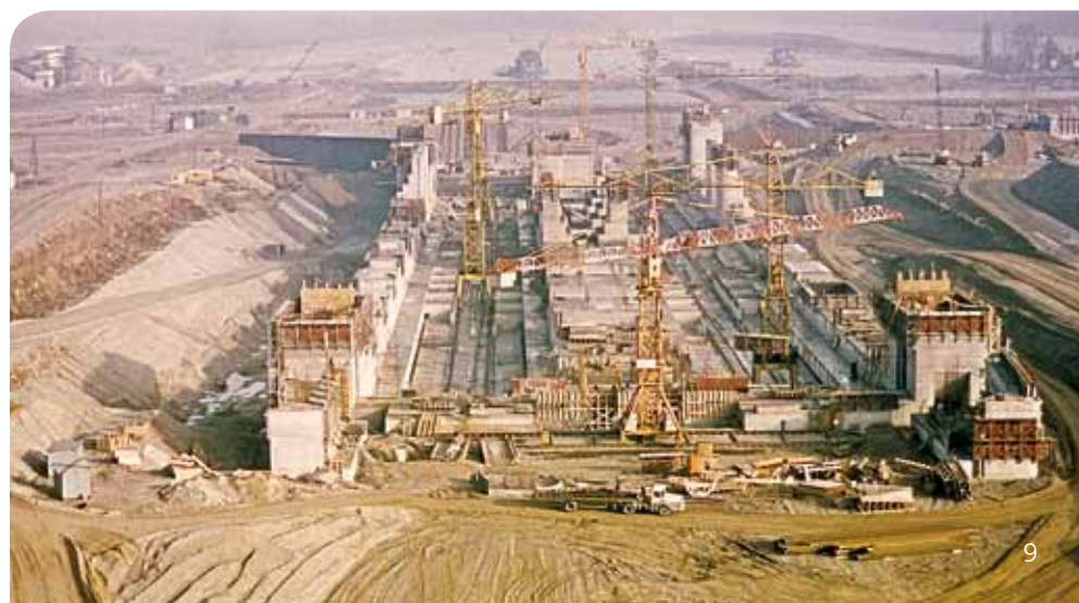
En 1973, le chantier des écluses de Gamsheim bat son plein.
