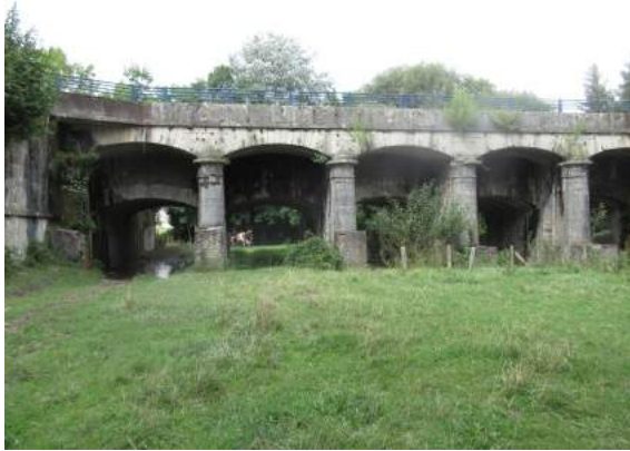
Le Pont-Canal de Wolfersdorf (à 8 km) permet aux péniches engagées sur le canal du Rhône au Rhin de franchir la rivière de la Largue.
