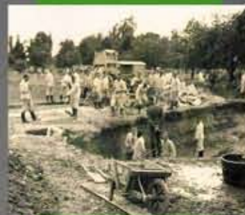
Construction de la Siedlung 1940
